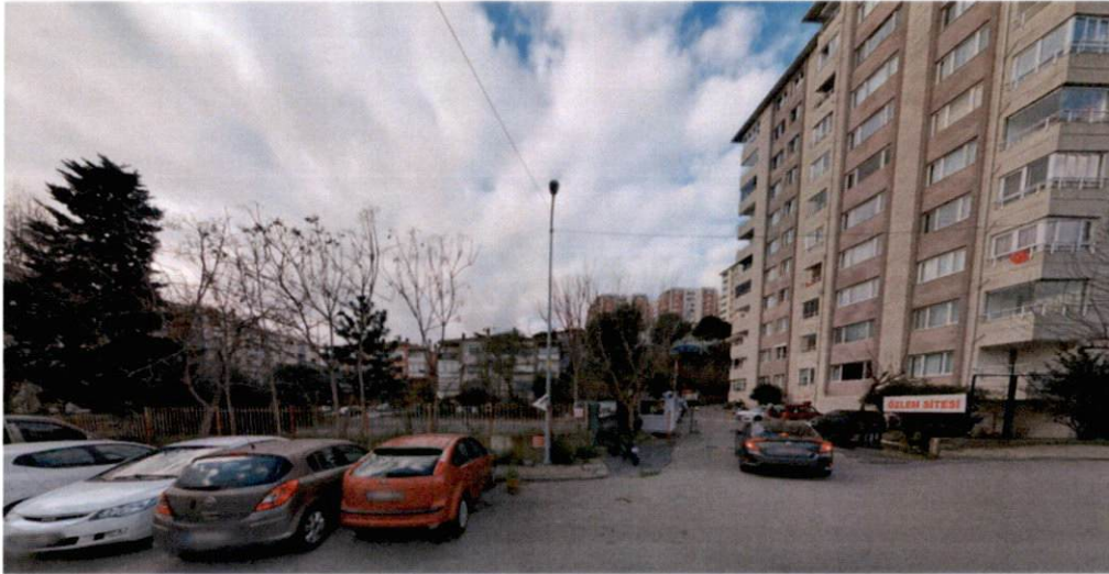
Fotoğraf 5 :7 metre en kesitli yol alanı (Şekercioğlu Sokak yönünden)
